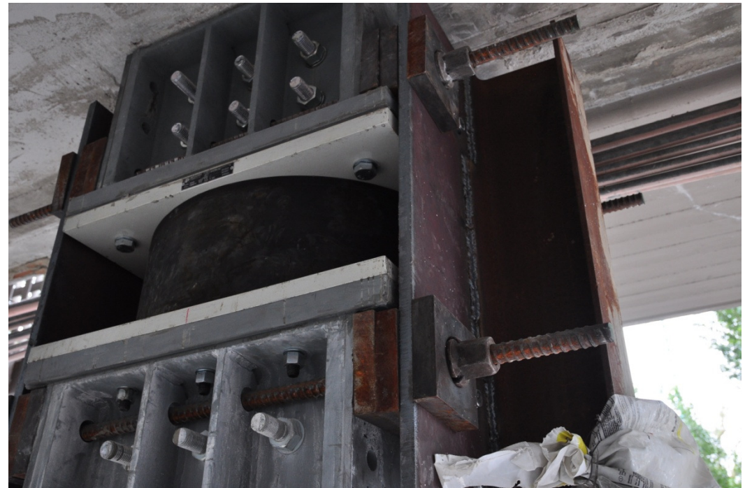
Isolatori elastomerici SI + appoggi multidirezionali VM
